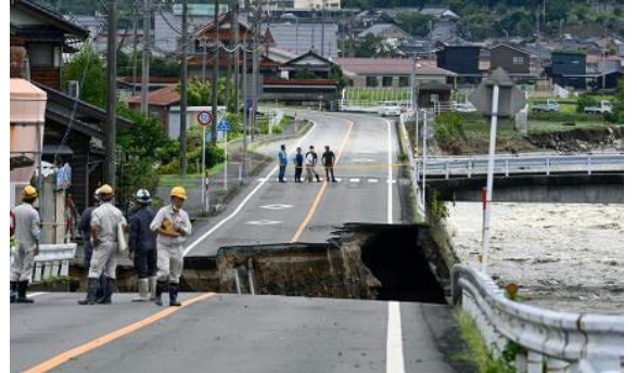
↑台風7号による被害（鳥取県）
